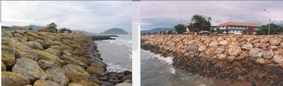
Gambar 7.1 Pembangunan Sea Wall Di Pesisir Pantai Sumatera Barat (Lokasi Pantai Kota Padang)
